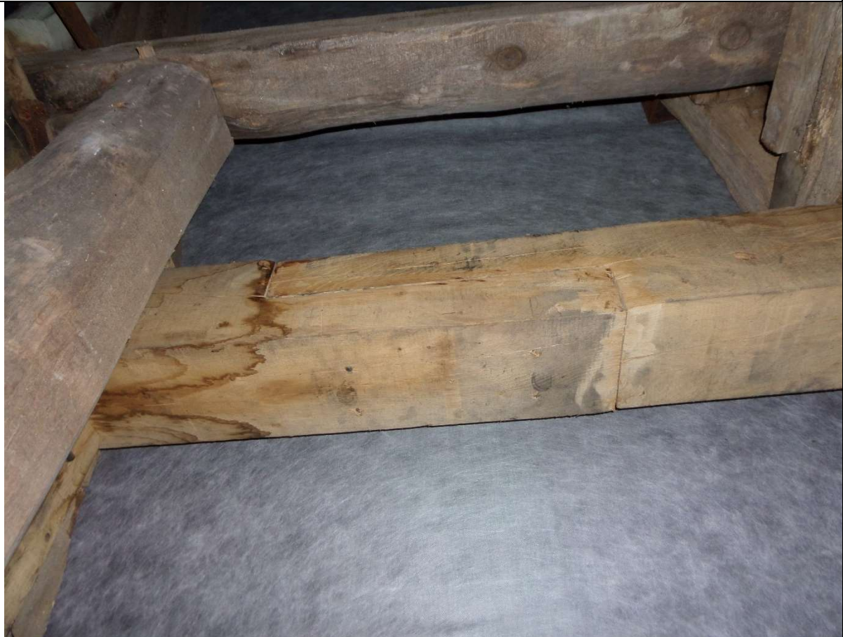
08. Erneuerung des Rähms in der 1. Ebene der Westseite
