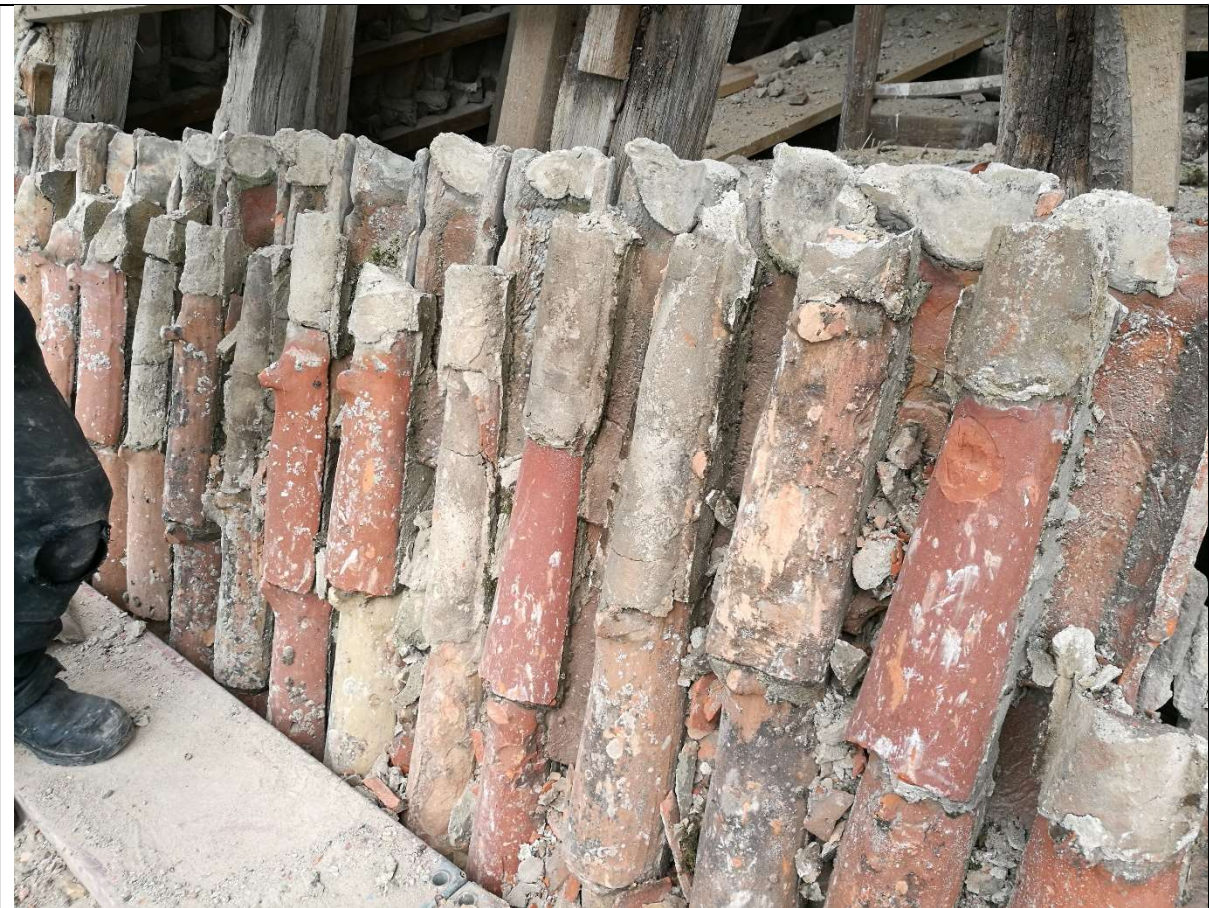
03 Abbruch der Dacheindeckung (starker Versatz in der Deckung)
