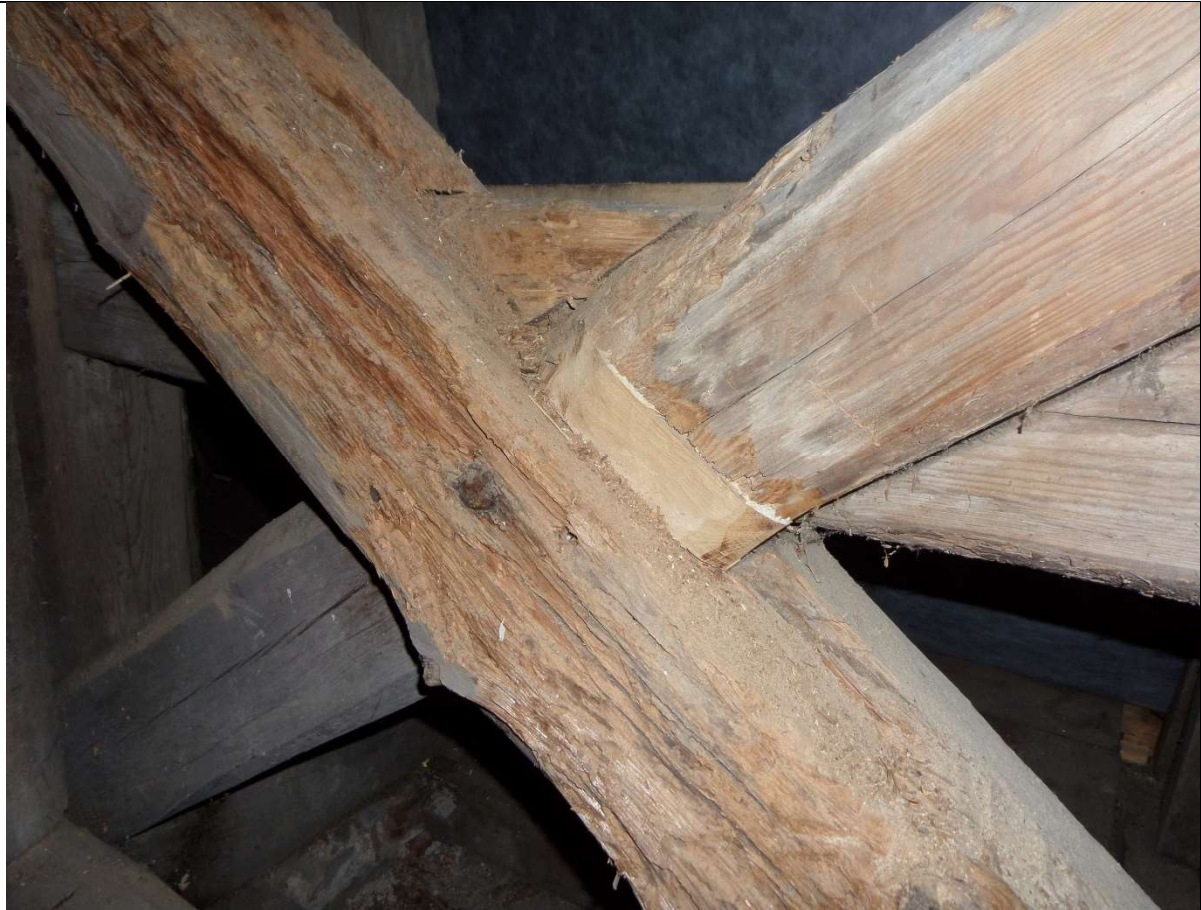
07. sanierte Holzverbindung
