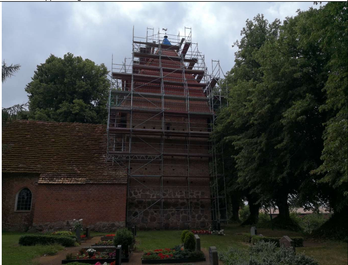
12. Nordseite kurz vor der Fertigstellung
