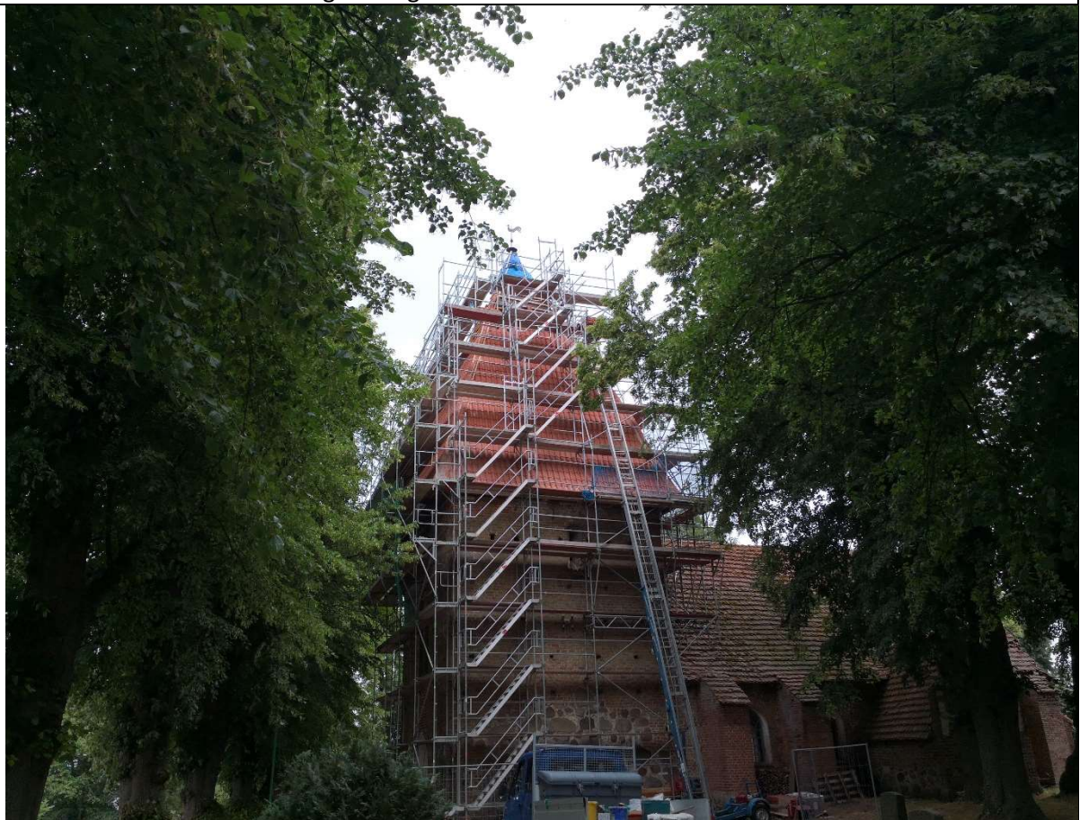
14. Südseite kurz vor der Fertigstellung
