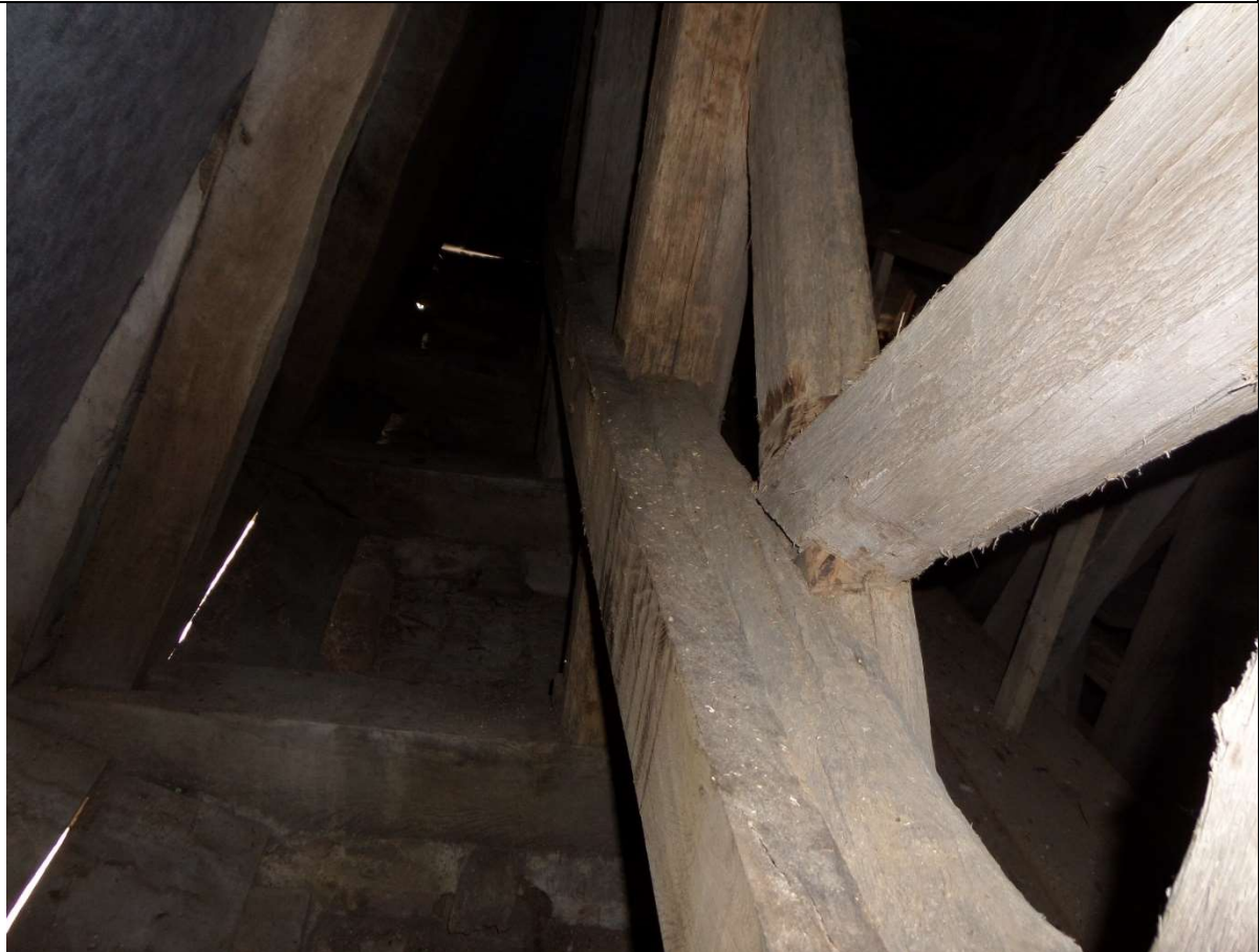
06 „Baubinde“ für den Ringschluss im Bereich der 1. Ebene
