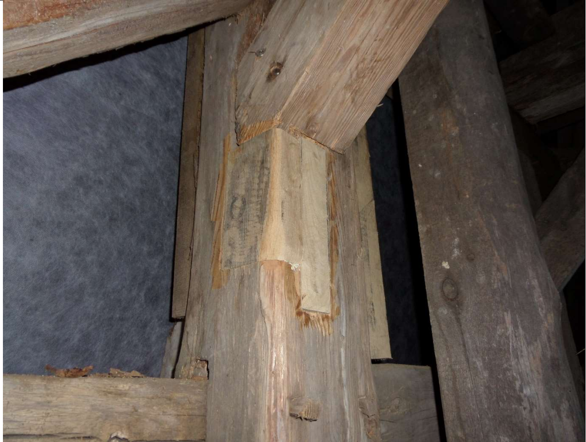
09. Instandsetzung Stiel im Bereich des Strebenanschlusses
