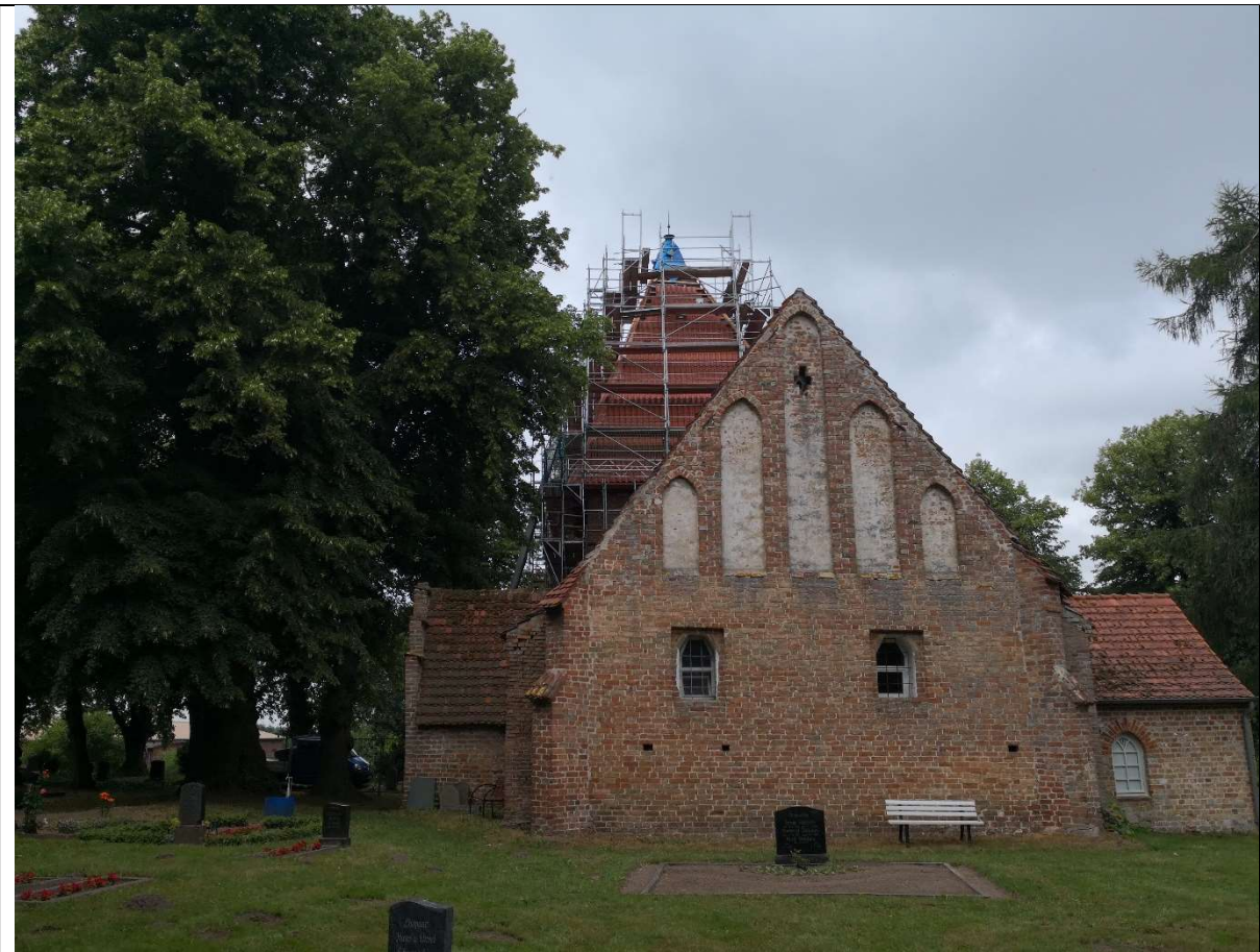
13. Ostseite kurz vor der Fertigstellung
