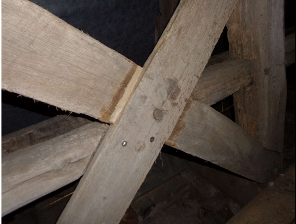
05 Sanierte Holzverbindung
