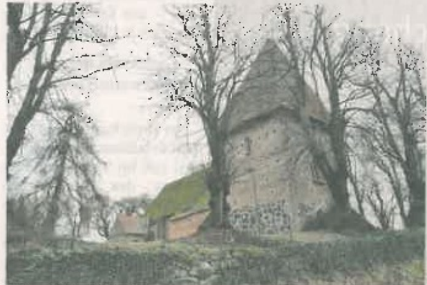
Hier auf der Kirche in Wiendorf liegen Ziegel der Kirche in Neukirchen, die dort 1986 beim Neueindecken aussortiert wurden. 2017 soll zunächst die Turmspitze saniert werden.
